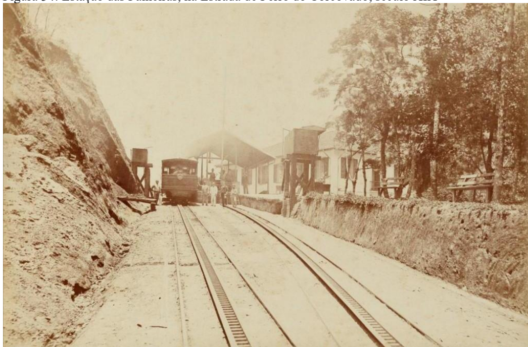
Figura 34: Estação das Paineiras, na Estrada de Ferro do Corcovado, século XIX
